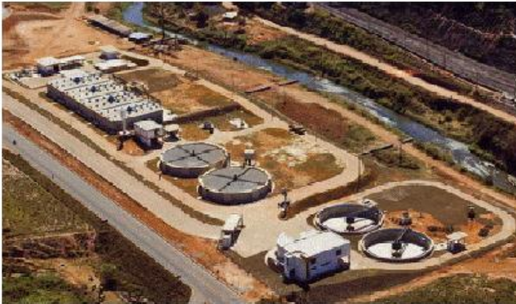
Figura 4.2 - Unidades de tratamento da ETE Laboreaux
