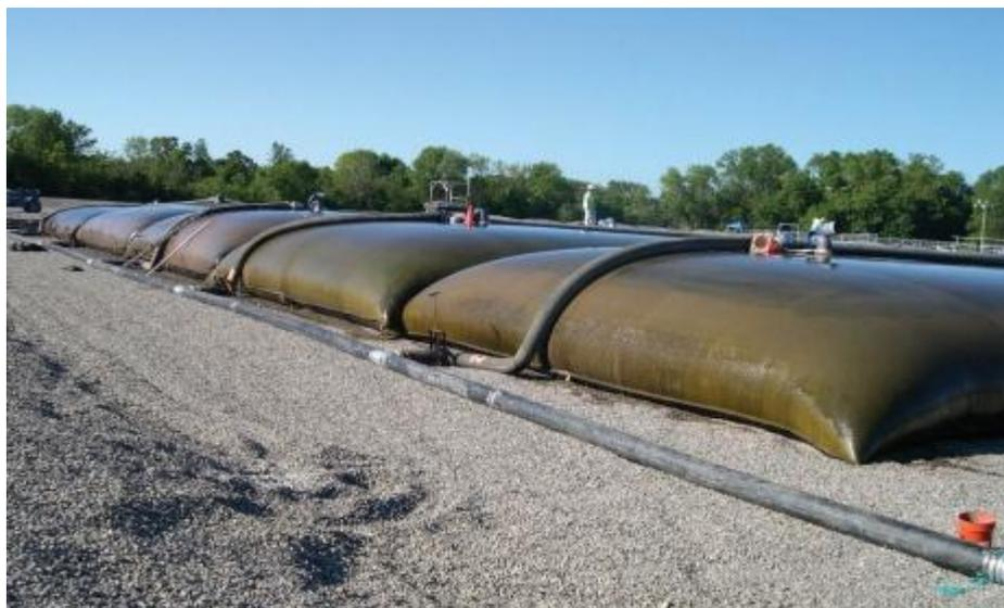
Figura 3.6: Bags horizontal de *geotube*
