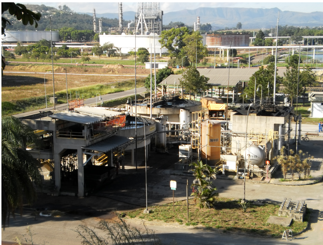
Figura 4. Vista Geral da Unidade de Flotação.
