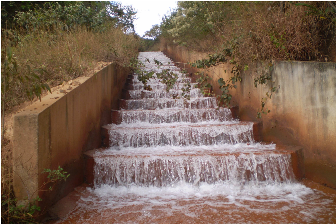
Foto 10: Escada de condução da água para reuso na produção (maio/2010).
