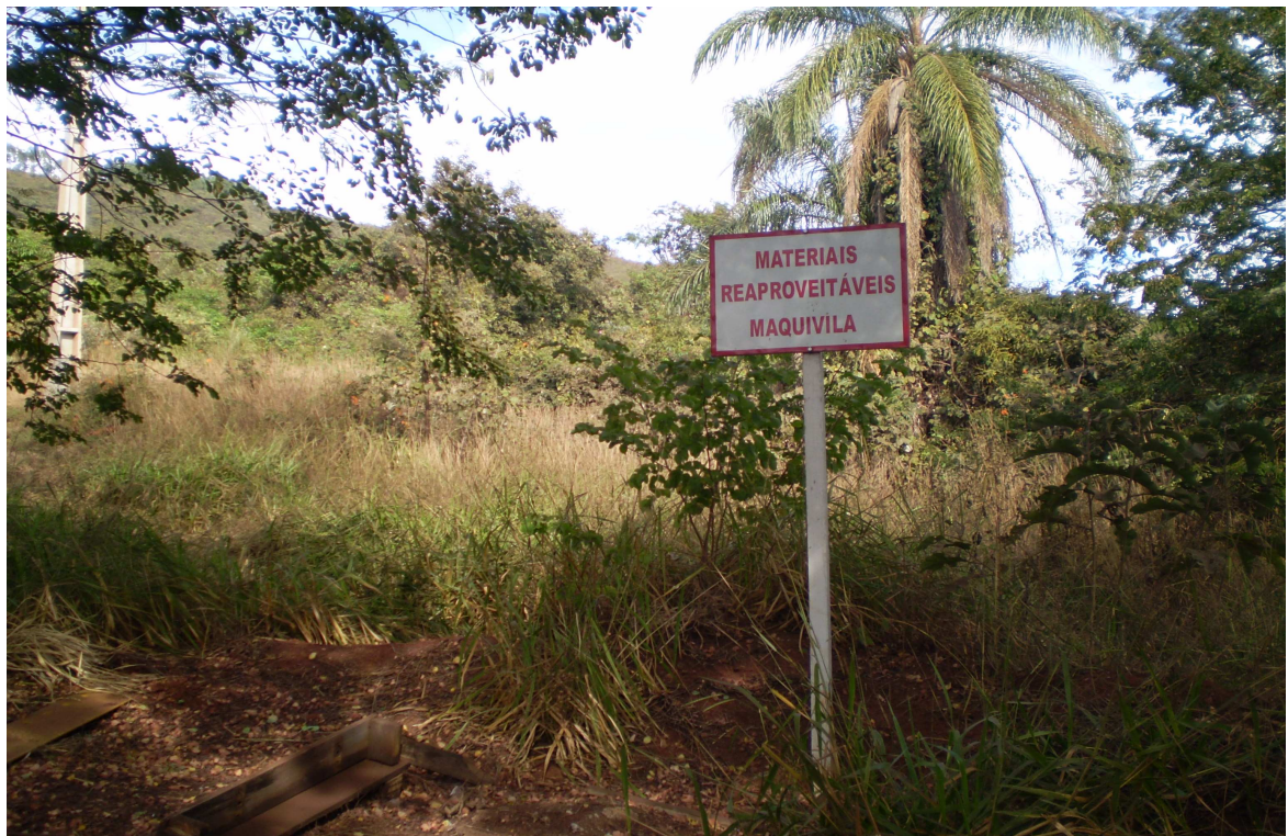
Foto 13: Abandono na área destinada aos materiais reaproveitáveis (maio/2010).
