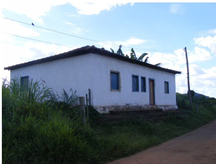
Figura 8 – Casa para revitalização e construção do CEA.
