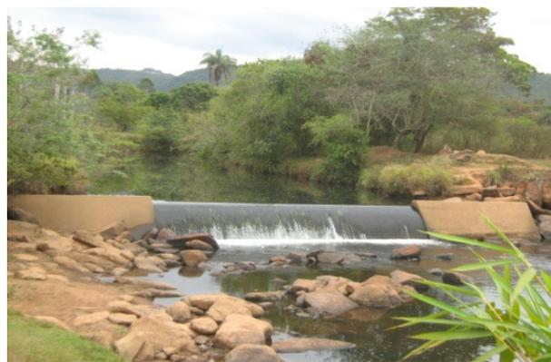
**FIGURA 5.2 - Barramento onde é feita a captação de água.**
