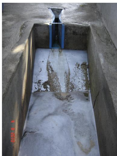
**Figura 4.2.** Peneira estática na saída do medidor Parshall
