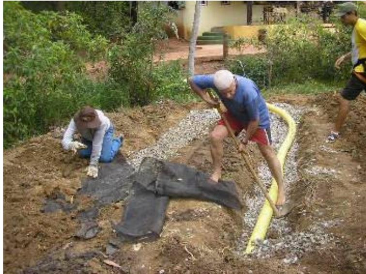
**FIGURA 9:** Detalhe da construção da Vala de Infiltração
