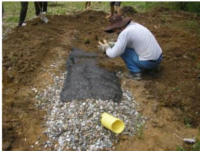
**FIGURA 10:** Detalhe construtivo das valas de infiltração
