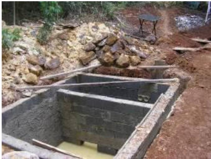
**FIGURA 8:** Detalhe da construção da Fossa Séptica
