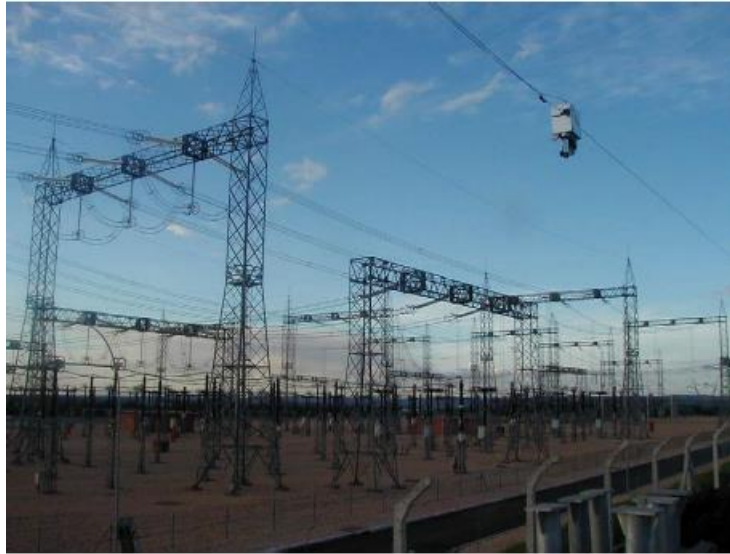
Figura 3.4 - Robô suspenso para monitoramento de subestações
