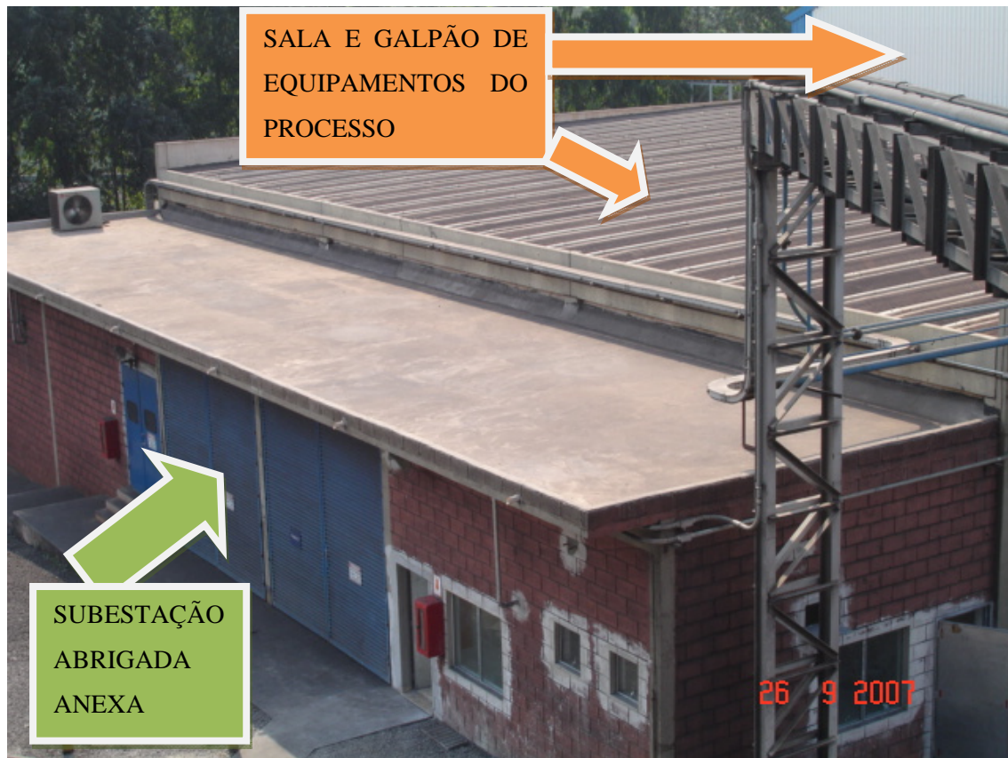
Figura 2.3 - Exemplo de subestação abrigada anexa à outra edificação.
