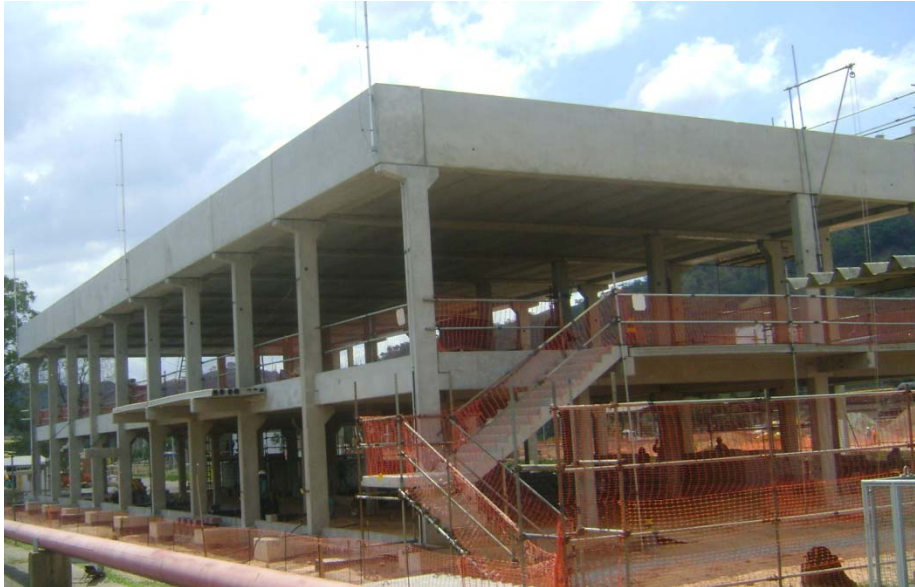
Figura 2.4 - Subestação abrigada com peças de concreto pré-moldado, em fase de construção.
