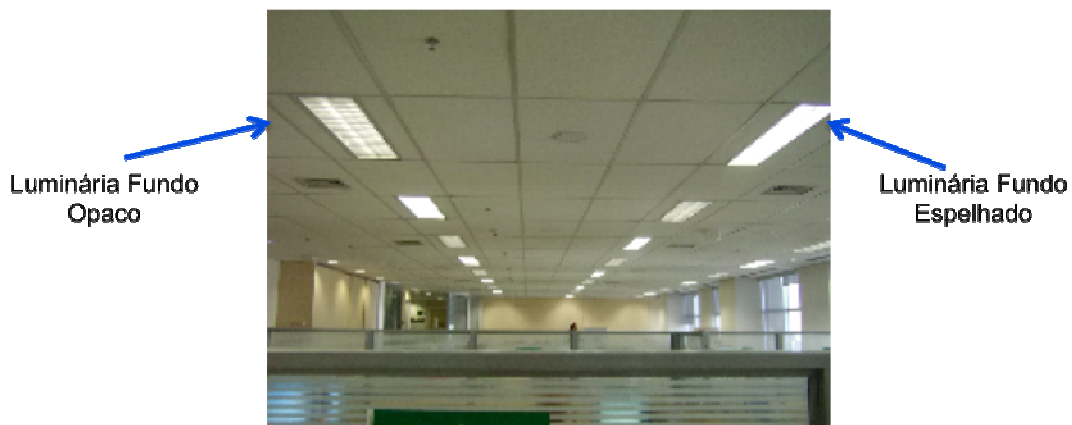
Figura 6 - Luminárias reflexivas e foscas intercaladas. Fonte: Foto realizada no setor em junho de 2010.
