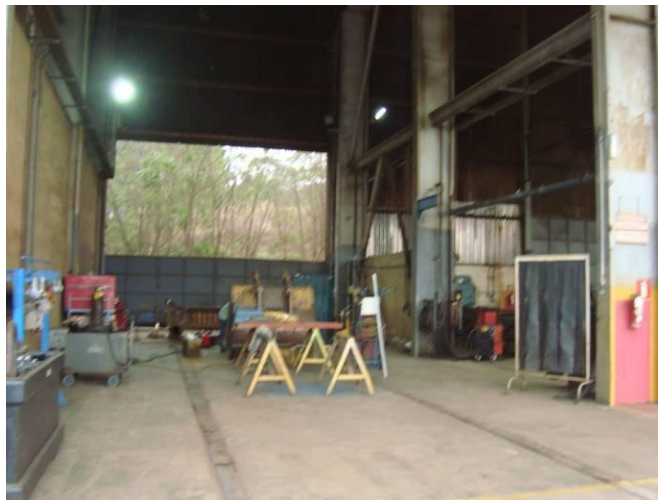
Figura 2 Visualização geral da oficina de manutenção.
