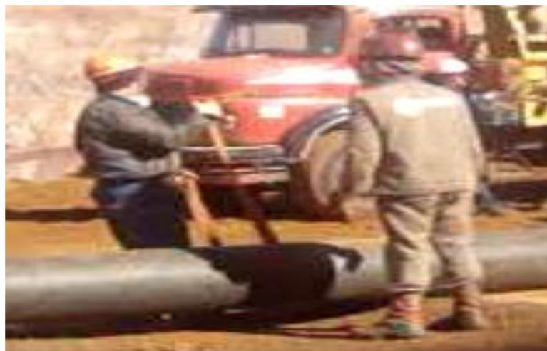
*Figura 7: Trabalhador posicionando a correia no tubo*
