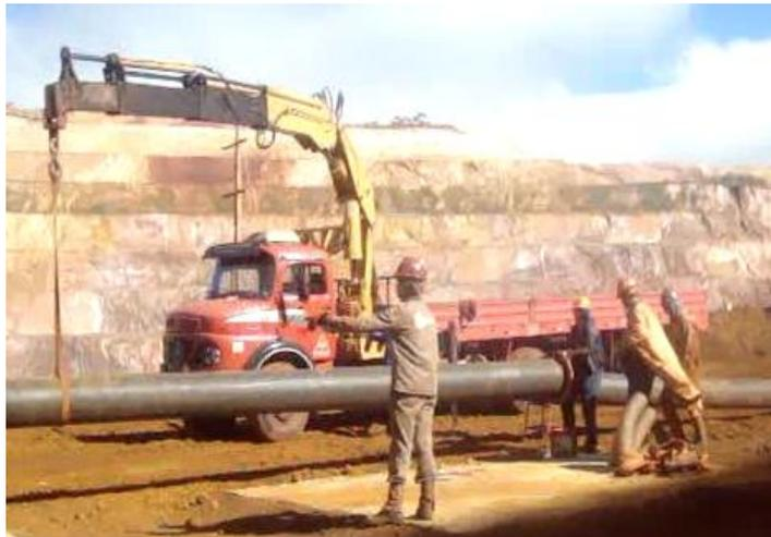
*Figura 8: Trabalhador direcionando o tubo para um novo local*
