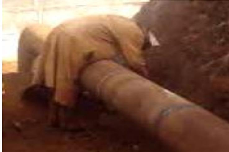
*Figura 5: Trabalhador realizando corte do tubo com o maçarico*
