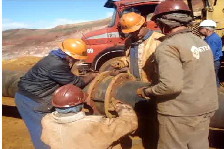
*Figura 9: Trabalhadores fazendo o acoplamento das flanges do tubo com os parafusos*
