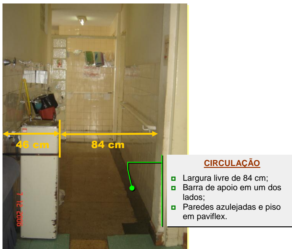
Figura 3 _ Corredor de acesso ao banheiro principal
