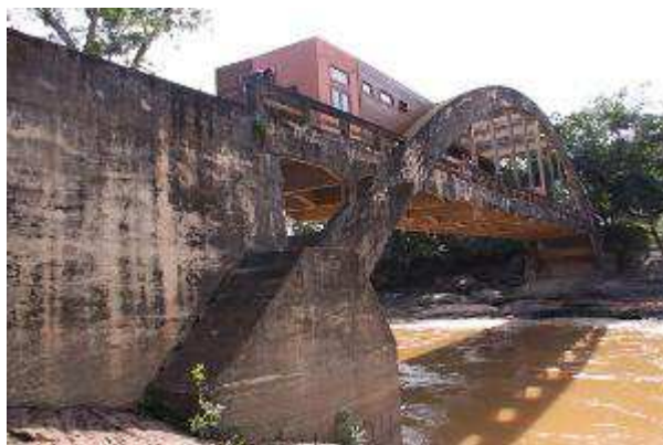
FIGURA 18 – A estrutura edificada.
