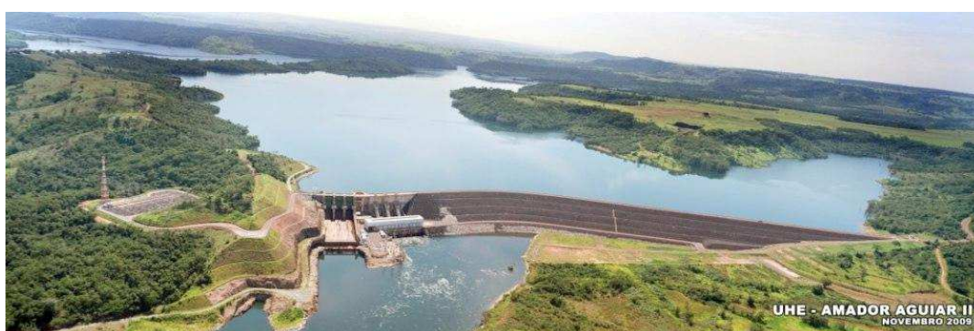
FIGURA 30 – Complexo Hidrelétrico de Amador Aguiar II.
