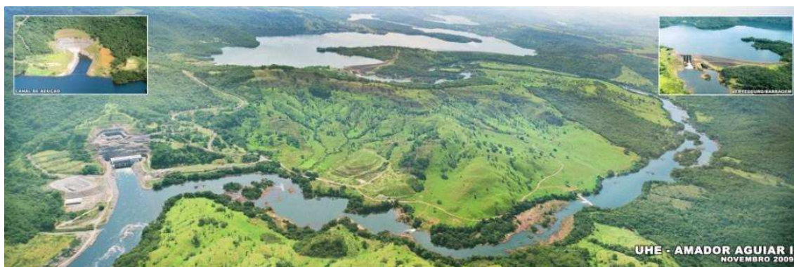
FIGURA 29 – Complexo Hidrelétrico de Amador Aguiar I.
