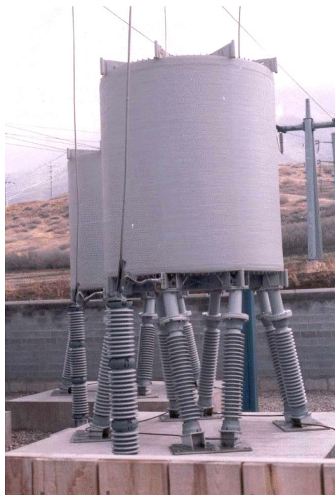
Figura 25. Reator Carbon-Spanish Fork; foto divulgação Trench Limited [19].
