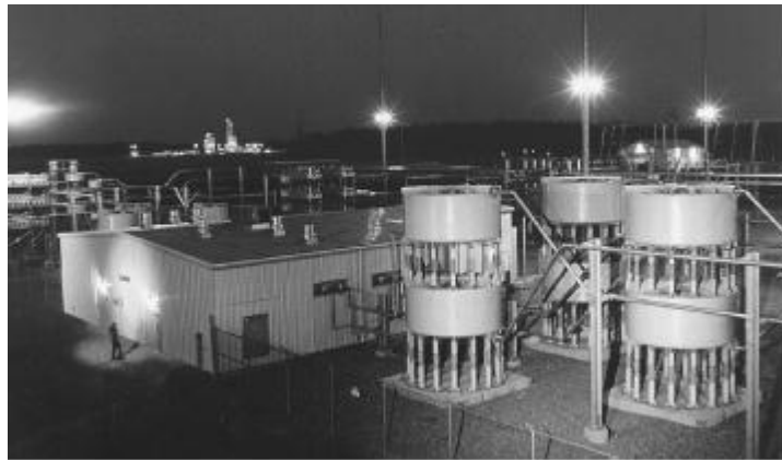
Figura 8. Reatores Controlados por Tiristores; retirada de [18].
