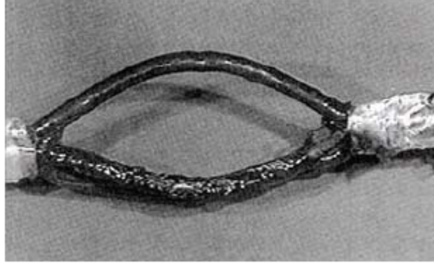
Figura 16: Condutor danificado após ocorrência de falta. Fonte: Extraído de SQUARE D, 2012.
