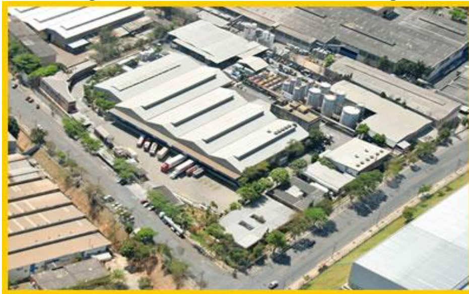
Figura 1 - Petronas Lubrificantes – Contagem/MG
