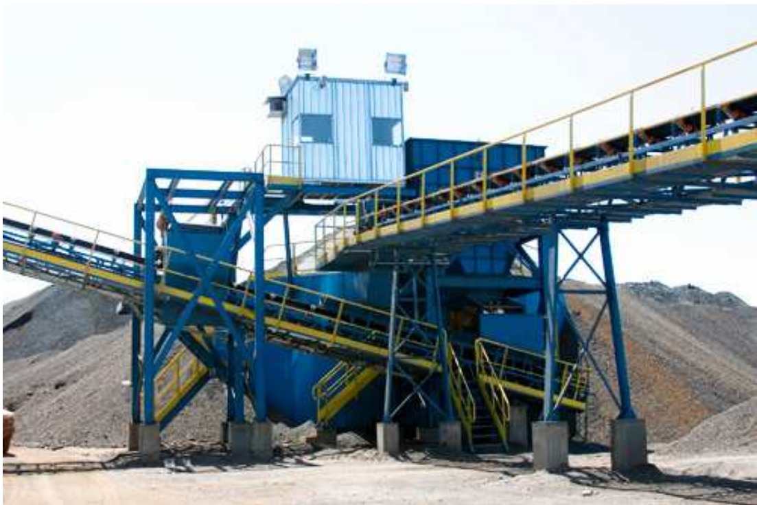
Figura 15: Estrutura metálica de sustentação (Fonte: web site da empresa, 2012)
