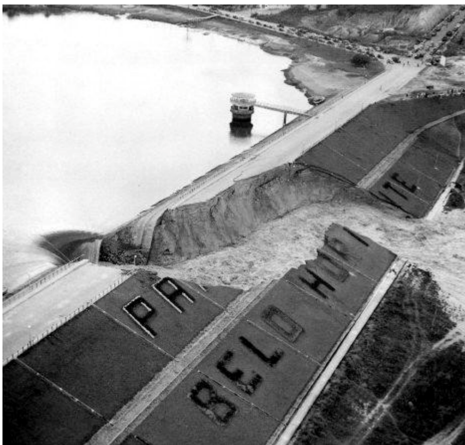
Figura 3- Rompimento da barragem da Pampulha- 1954
