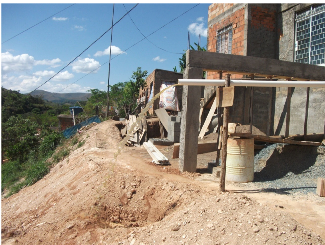
Figura 11: Esgoto sendo lançado a “céu aberto” no bairro Vila Nova por falta de rede coletora (Outubro de 2012). Autor: Matheus D. Santos
