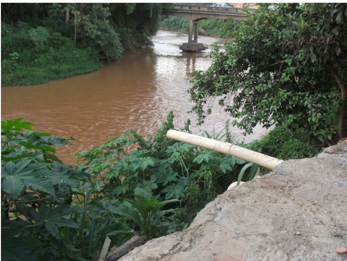
Figura 10: Esgoto sendo despejado no Rio das Velhas (Outubro de 2012). Autor: Matheus D. Santos
