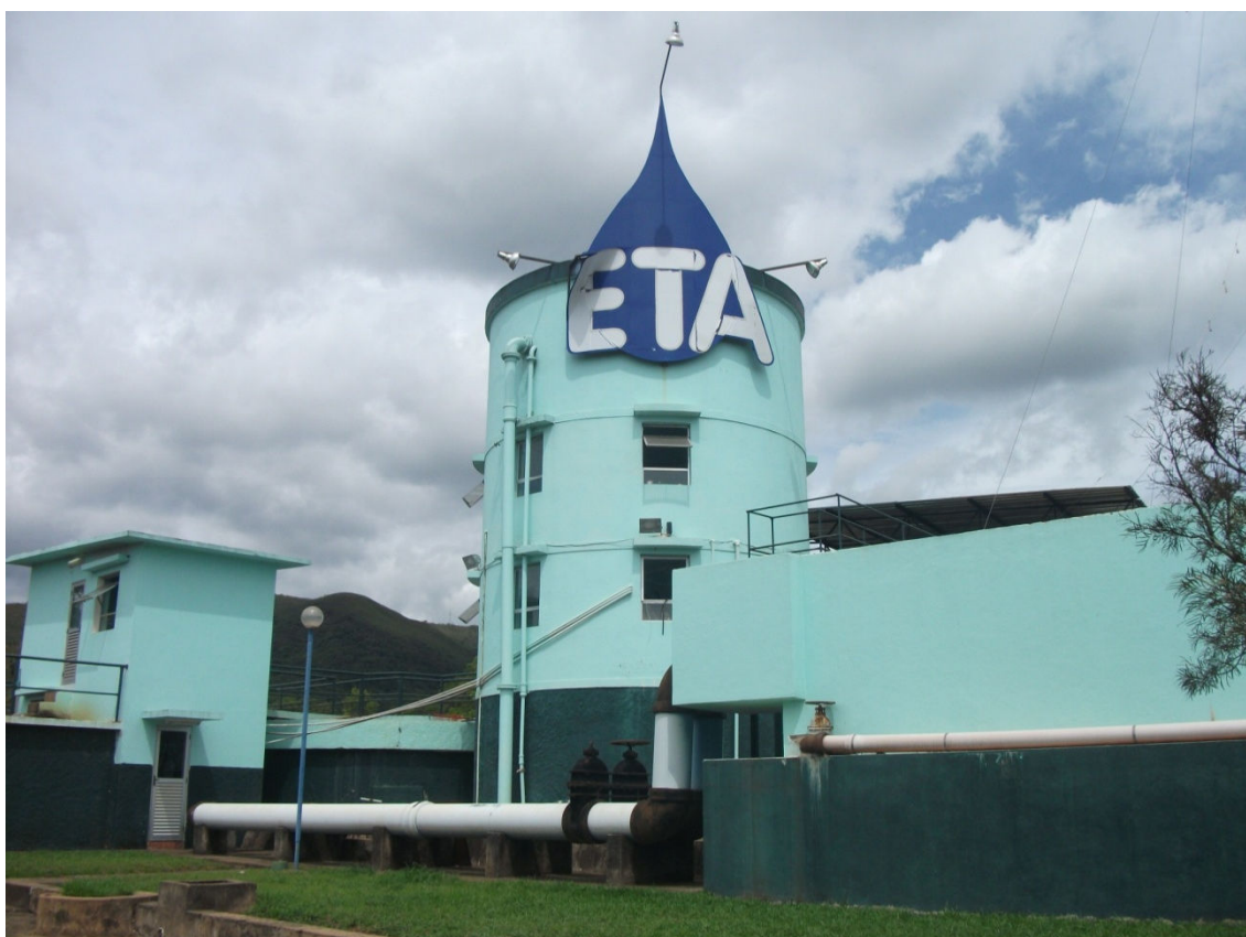
Figura 5: Estação de Tratamento de Água – ETA. (Outubro de 2012) Autor: Matheus D. Santos
