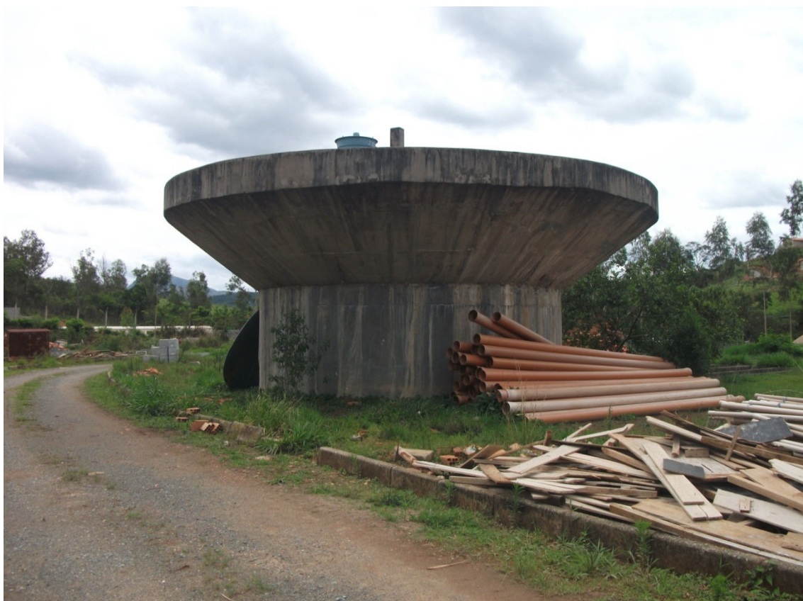
Figura 6: Estação de Tratamento de Esgoto do Bairro Vila Duarte – ETE. (Outubro de 2012) Autor: Matheus D. Santos
