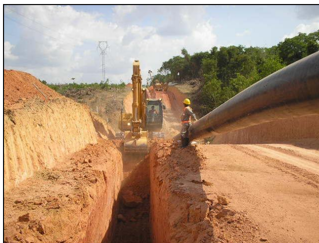
Figura 4.9: Abertura de vala (AUSENCOPSI, 2006 b).
