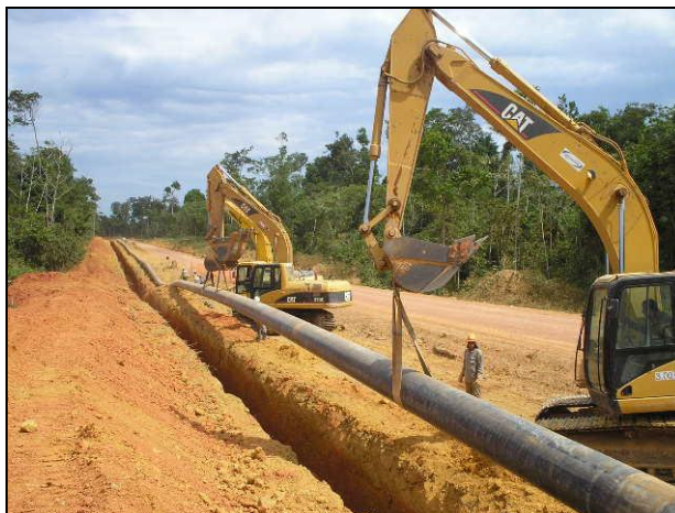
Figura 4.12: Abaixamento do tubo (AUSENCOPSI, 2006 b).
