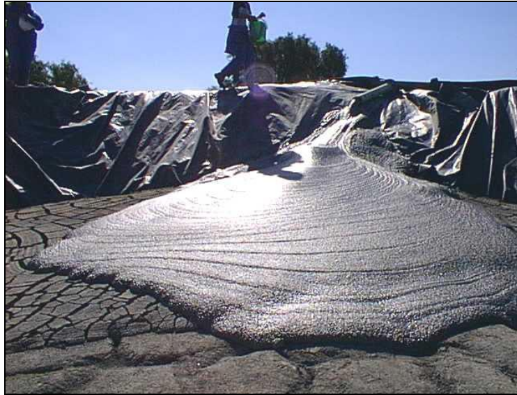
Figura 3.3: Barragem de Rejeito Espessado (Pimenta de Ávila, 2008)
