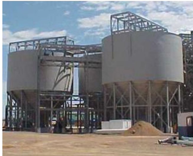
Figura 3.6: Espessador de Pasta – Deep Cone (Delkor, 2010)
