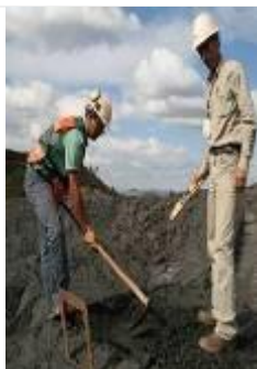
Figura 6.3: Nivelando a área.(Abreu, 2009).
