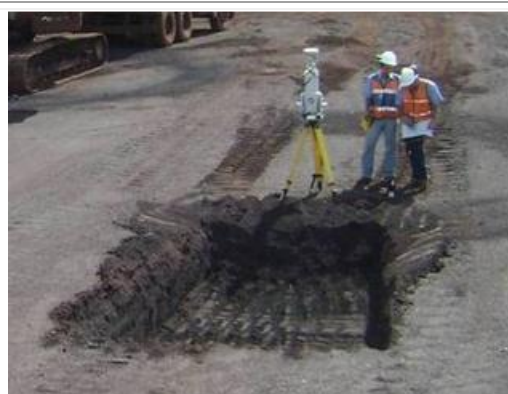
Figura 6.33: Exemplo de medição topográfica de trincheira (Cruz, 2009).
