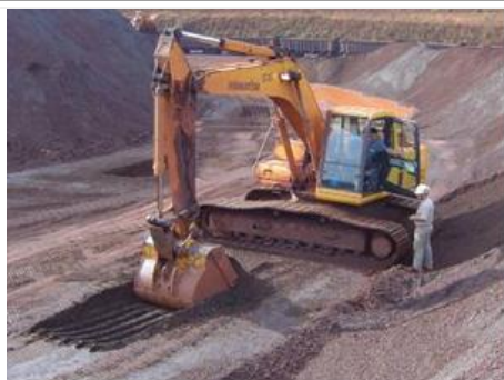
Figura 6.30: Retroescavadeira realizando abertura de trincheira (Cruz, 2009).
