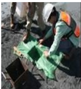
Figura 6.11: Revestindo o poço com plástico (Abreu, 2009).
