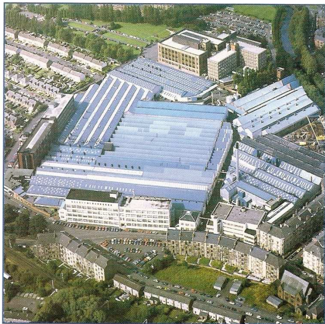
Weir Pumps - Glasgow - Escócia
