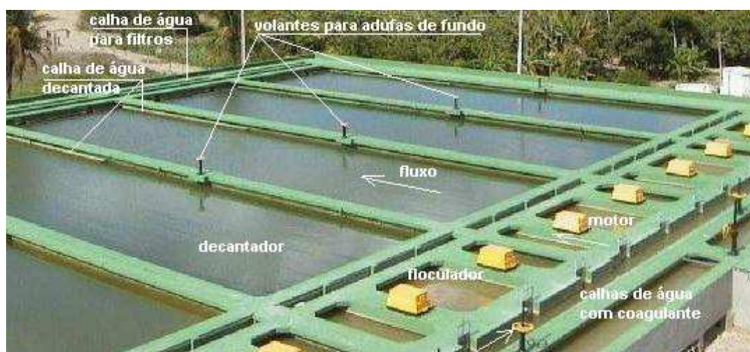
FIGURA 3.14: Decantador convencional de fluxo horizontal (GUIMARÃES, 2007).
