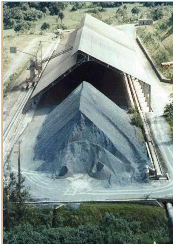
Figura 3.2: Stacker e pilha da pré-homogeneização (ECL, 2009)
