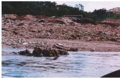
assoreamento de rio
