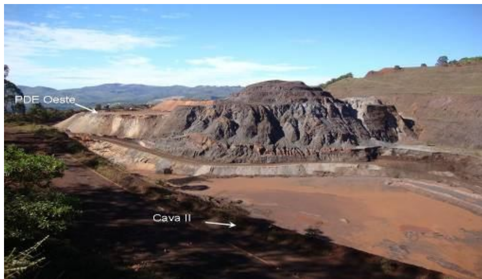
Foto 3.3.1.2: Barragem da Cava II – Fonte: Vale, 2010.
