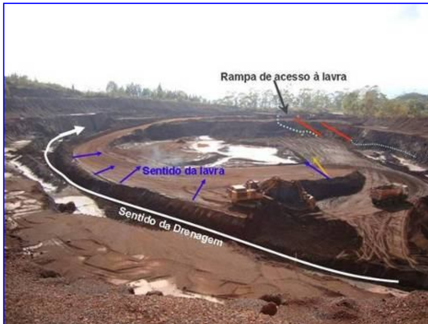
Figura 3.4.4: Barragem Cava X. Fonte: Vale, 2010
