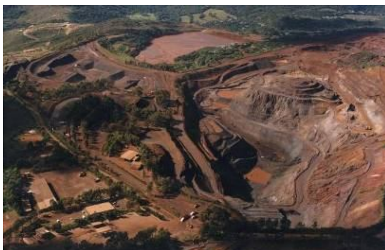
Foto 3.3.1.3: Barragem da Cava II – Fonte: Vale, 2000.
