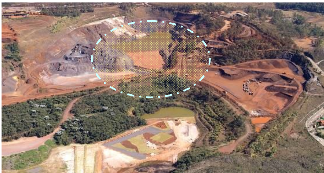
Foto 3.3.1.1: Barragem da Cava II – Fonte: Vale, 2004.
