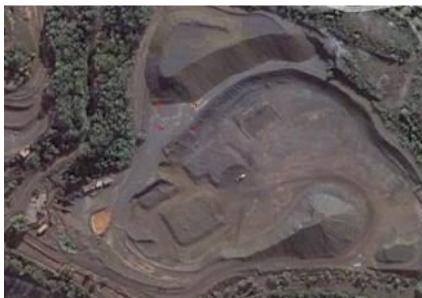
Figura 3.4.1: Área E1, Barragem Cava X Mar Azul. Fonte: Vale, 2010
