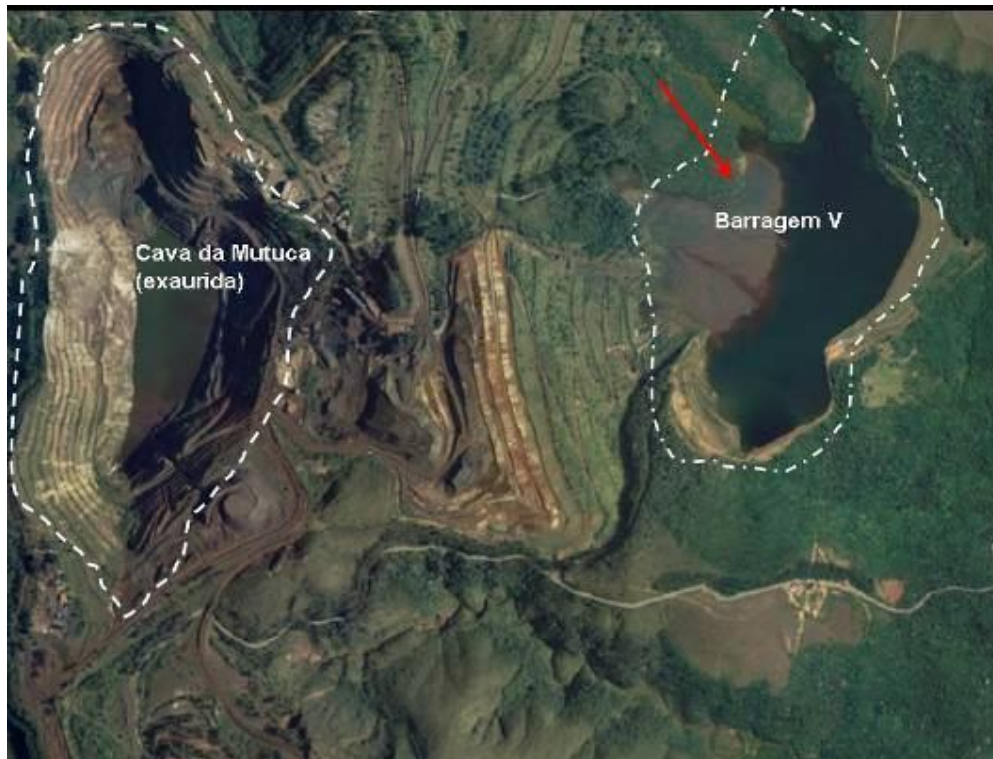
Figura 3.8.1 – Barragem V e Cava da Mutuca. Fonte: Vale, 2011.
