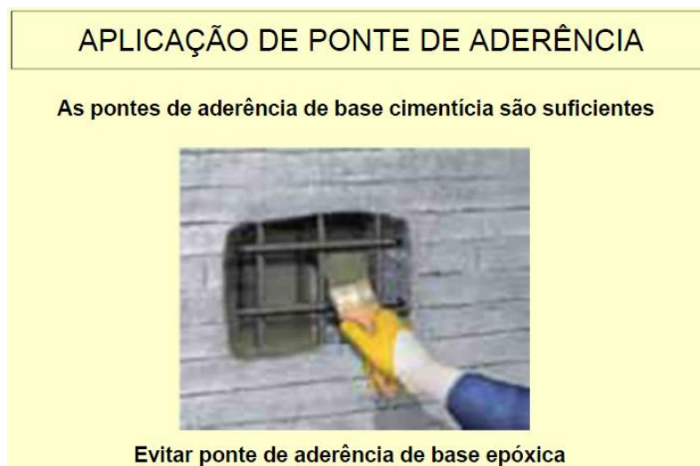
Figura 20 – Aguiar J. – Apostila Mecanismo de Deterioração do Concreto - Aplicação de ponte de aderência.
