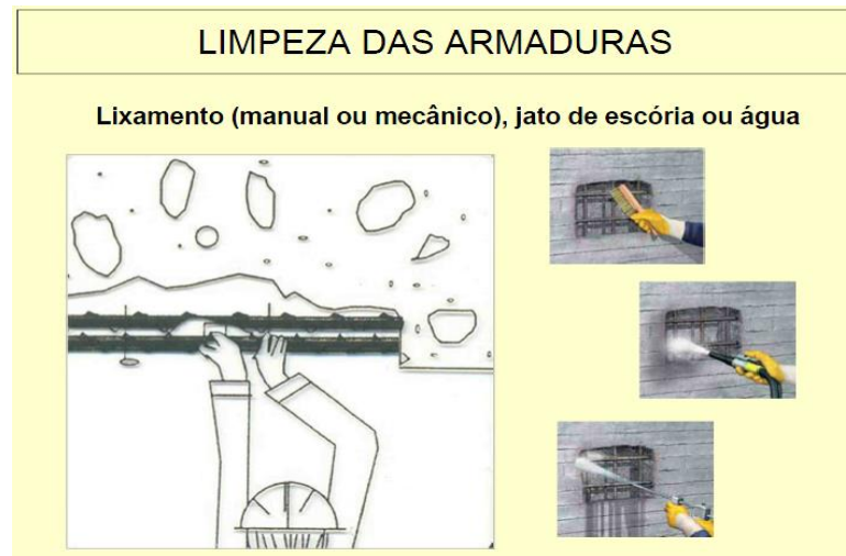
Figura 15 – Aguiar J. – Apostila Mecanismo de Deterioração do Concreto - Limpeza das armaduras.
