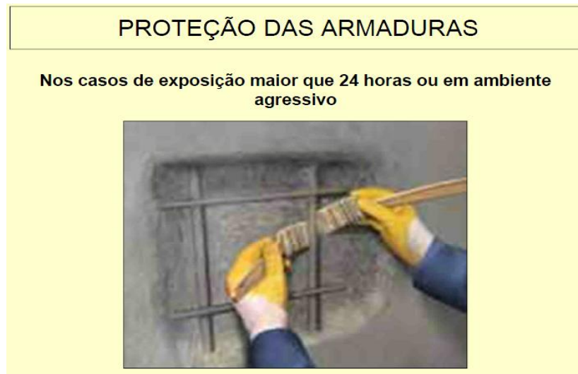
Figura 16 – Aguiar J. – Apostila Mecanismo de Deterioração do Concreto - Proteção das armaduras.
