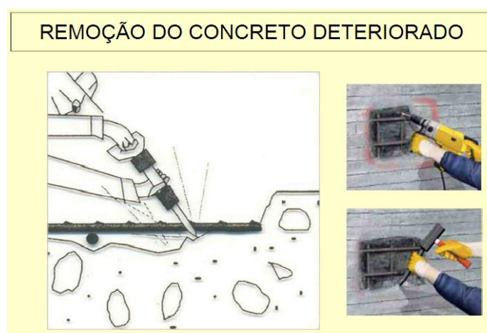
Figura 12 – Aguiar J. – Apostila Mecanismo de Deterioração do Concreto - Remoção do concreto deteriorado.
