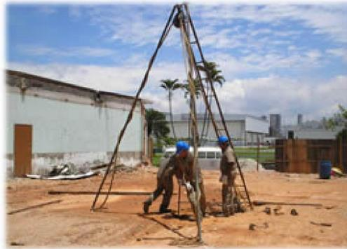
**Figura 2 - Processo de sondagem à percussão [2]**
