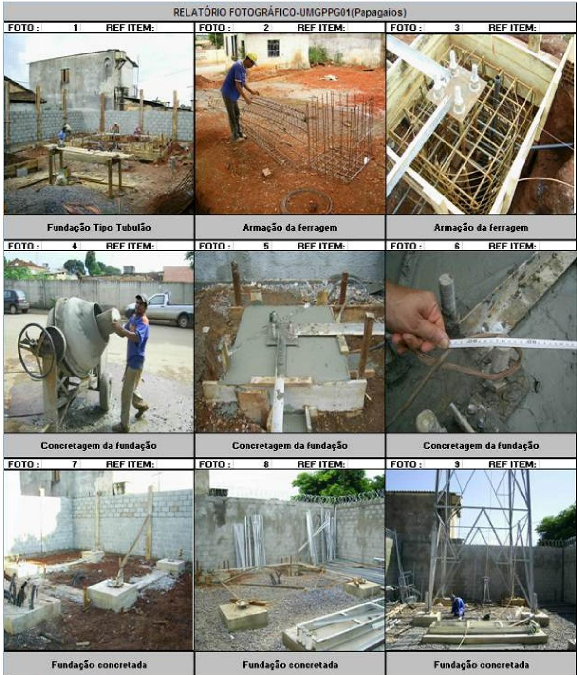
Figura 11 - Relatório fotográfico da fundação tubulão do *site* UMGPPG01 [7]
