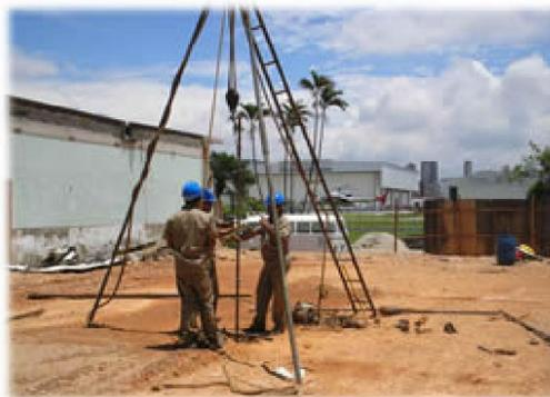
**Figura 4 - Processo de sondagem à percussão [2]**
