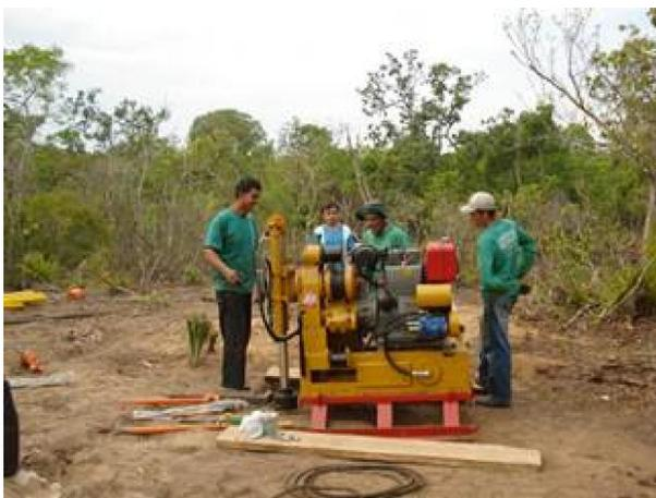
**Figura 5 - Processo de sondagem rotativa [3]**
