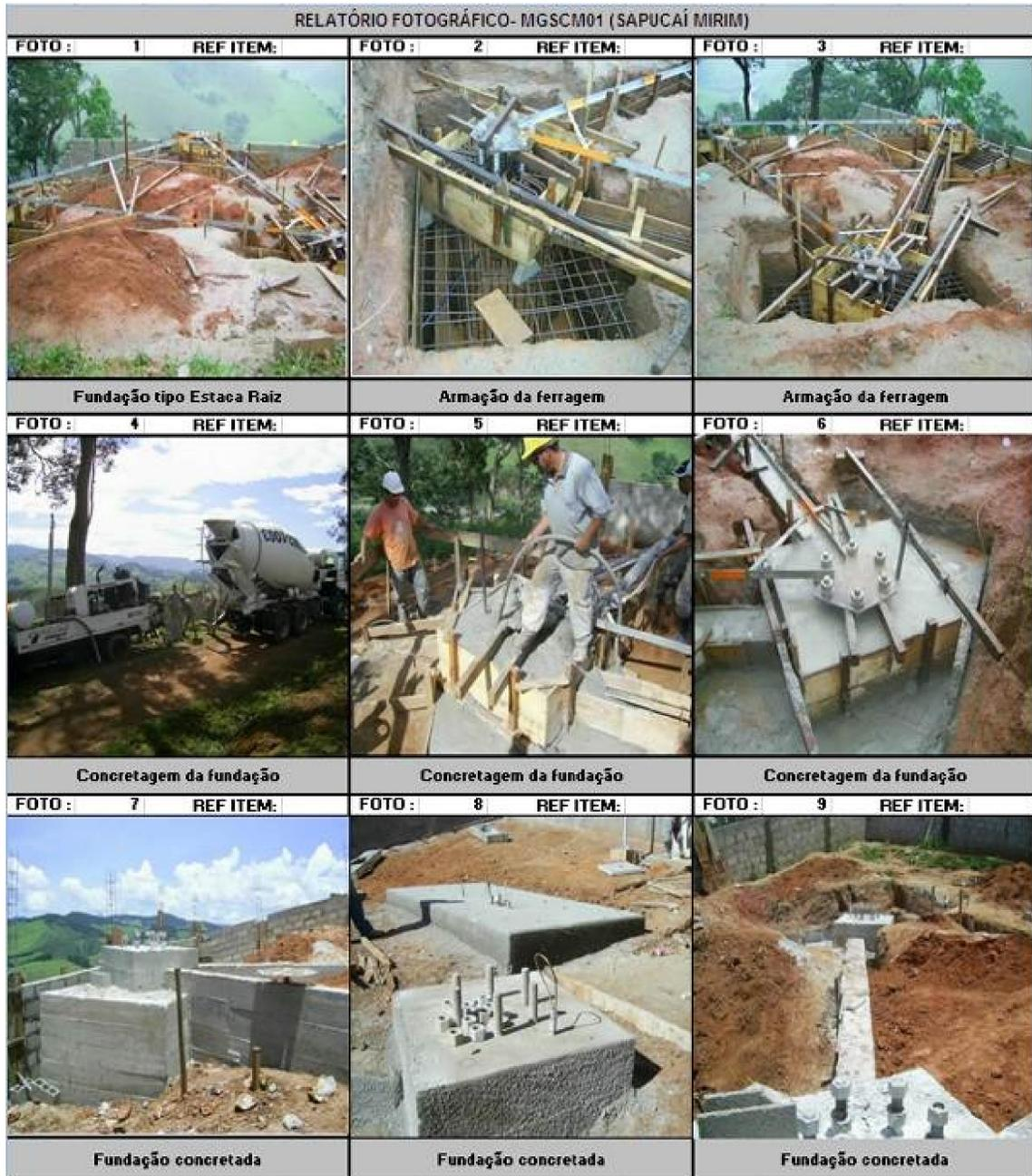
Figura 18 - Relatório fotográfico da fundação estaca raiz do *site* UMGSCM01 [7]
