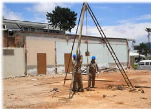
**Figura 3 - Processo de sondagem à percussão [2]**
