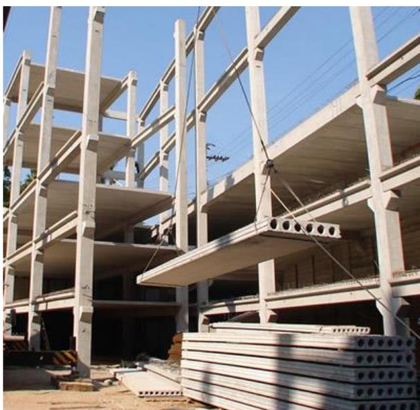
*Figura 11 - Imagem típica de uma laje alveolar de concreto pré-fabricado sendo içada para o local de aplicação final em um edifício de múltiplos pavimentos. Retirado de <http://www.premodisa.com.br/produtos/lajes>, visitado em janeiro de 2013*
