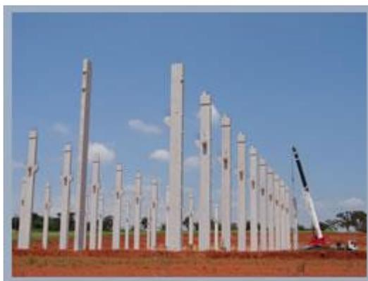
Figura 12 – Sequencia de pilares pré fabricados locados na posição de receber as vigas de travamento e as lajes. Retirado de <http://www.premodisa.com.br/produtos/lajes>, visitado em janeiro de 2013.
