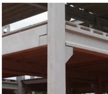
Figura 13 – Exemplo de apoio de viga em pilar. À esquerda apresenta-se a viga, de seção quadrada, com o apoio de mísula tipo dente gerber. Neste caso o arremate resultante é regular, permitindo uma maior racionalização no requadro de vedação que poderá ser instalado posteriormente. À direita a viga, de seção 'I', a mísula do tipo trapezoidal. Retirado de <http://www.premodisa.com.br/produtos/lajes>, visitado em janeiro de 2013.
