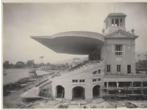
*Figura 6 – Hipódromo da Gávea - Rio de Janeiro (1962). Primeira grande obra a utilizar peças pré-moldadas de concreto no Brasil. Retirado de <http://007bondesportes.blogspot.com.br/2011/08/gp-brasil-2011-no-hipodromo-da-gavea-o.html>, visitado em janeiro de 2013.*
