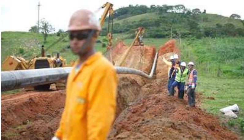
Figura 3: Instalação das tubulações. Fonte: Anglo American/ Divulgação.
