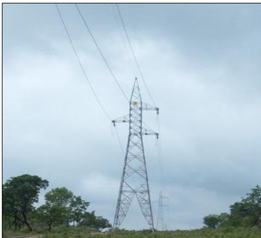
Figura 5.2 – Estrutura típica da linha de transmissão estudada.
