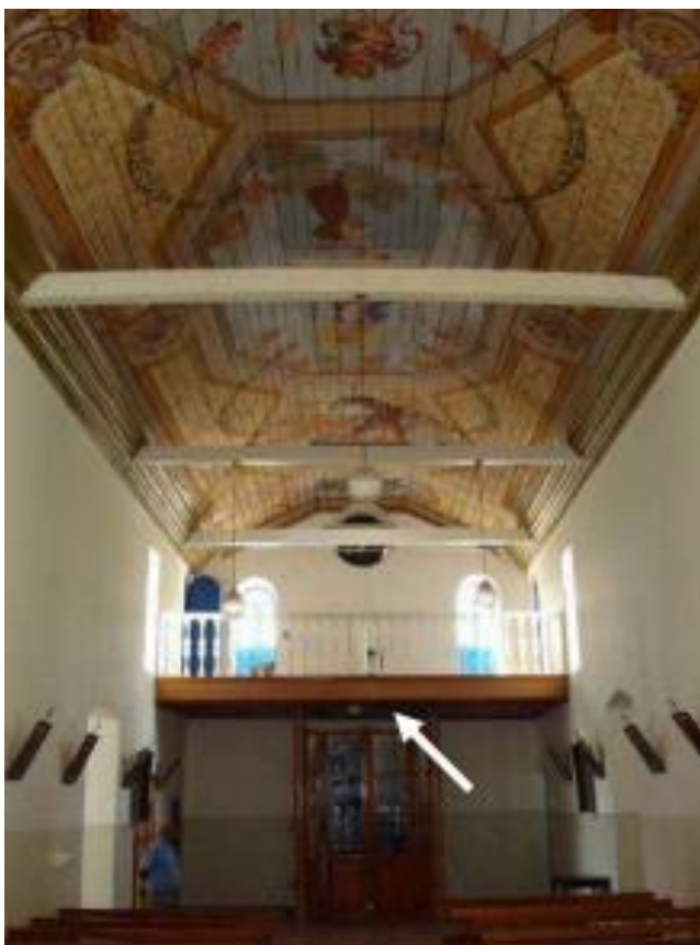
Imagem 07: Nave da Igreja de Santo Antônio, distrito Santo Antônio do Leite.
