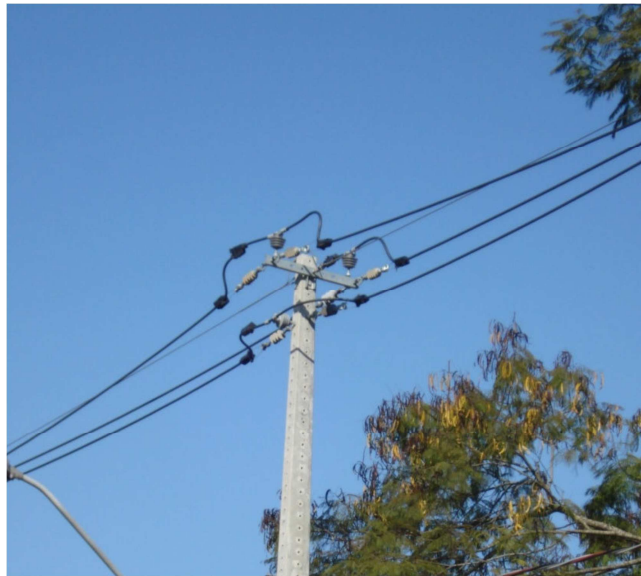
Figura 2.6 – Trecho de rede compacta, estrutura de ancoragem
