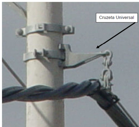
Figura 3.2 – Estrutura passante de rede de distribuição isolada.
