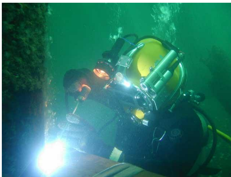
Figura 1.1: Soldagem subaquática molhada por eletrodo revestido.
