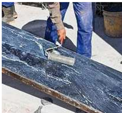
FIGURA 5.7: Desmoldante aplicado na fôrma. Fonte:
