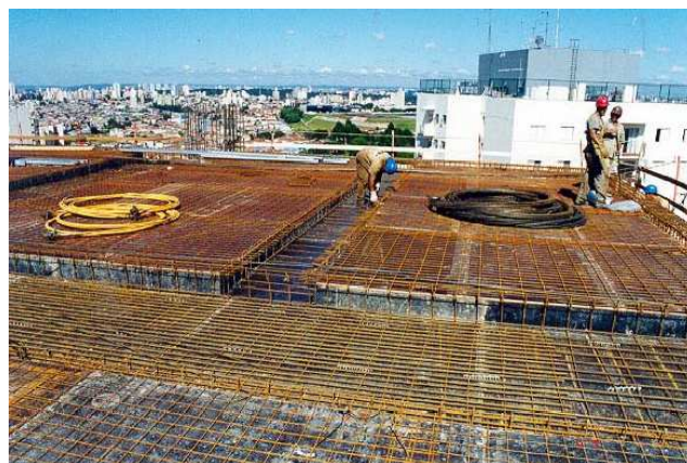
FIGURA 5.4: Posicionamento da armação da laje.
