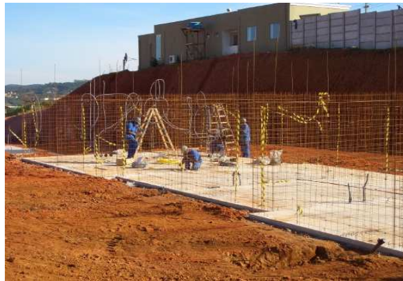
FIGURA 5.3: Posicionamento da armação para as paredes de concreto.
