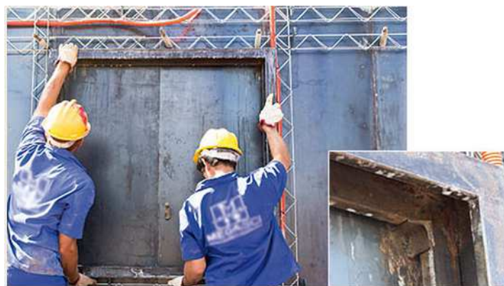
FIGURA 5.9: Fôrma da janela. Fonte: ( http://www.equipedebra.com.br/construcao-reforma/37/artigo220698-1.asp )
