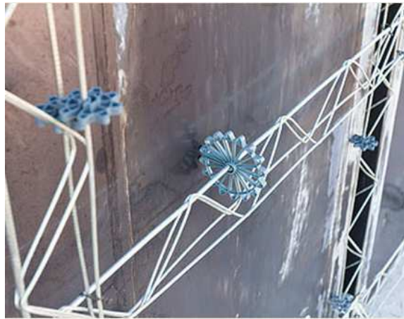
FIGURA 5.8: Detalhe dos espaçadores. Fonte:
