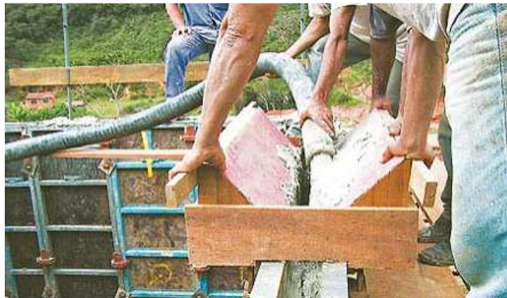
FIGURA 5.11: Parede fechada com as formas externa e interna. Fonte: ( http://www.bps.com.br/ibts/news/paredes_concreto.pdf )
