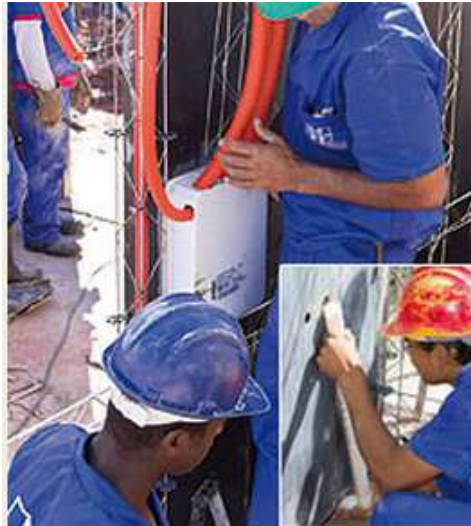
FIGURA 3.5: Instalação da caixa de passagem na fôrma para posterior concretagem.
