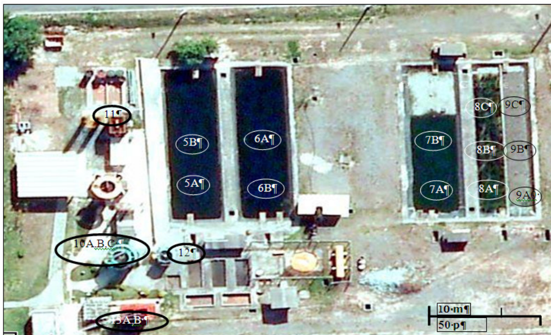
Figura 4.2 - Foto de satélite do CePTS com destaque para os sistemas escolhidos: Lagoas de Polimento (5, 6, e 7), Wetlands construídas (8 e 9) Reatores UASB 10, 11, 12, 13.
