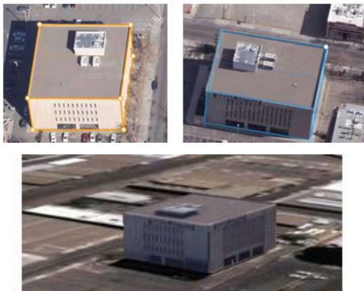
FIGURA 61 – Exemplo de encaixe dos blocos na edificação e processo de texturização automático.
