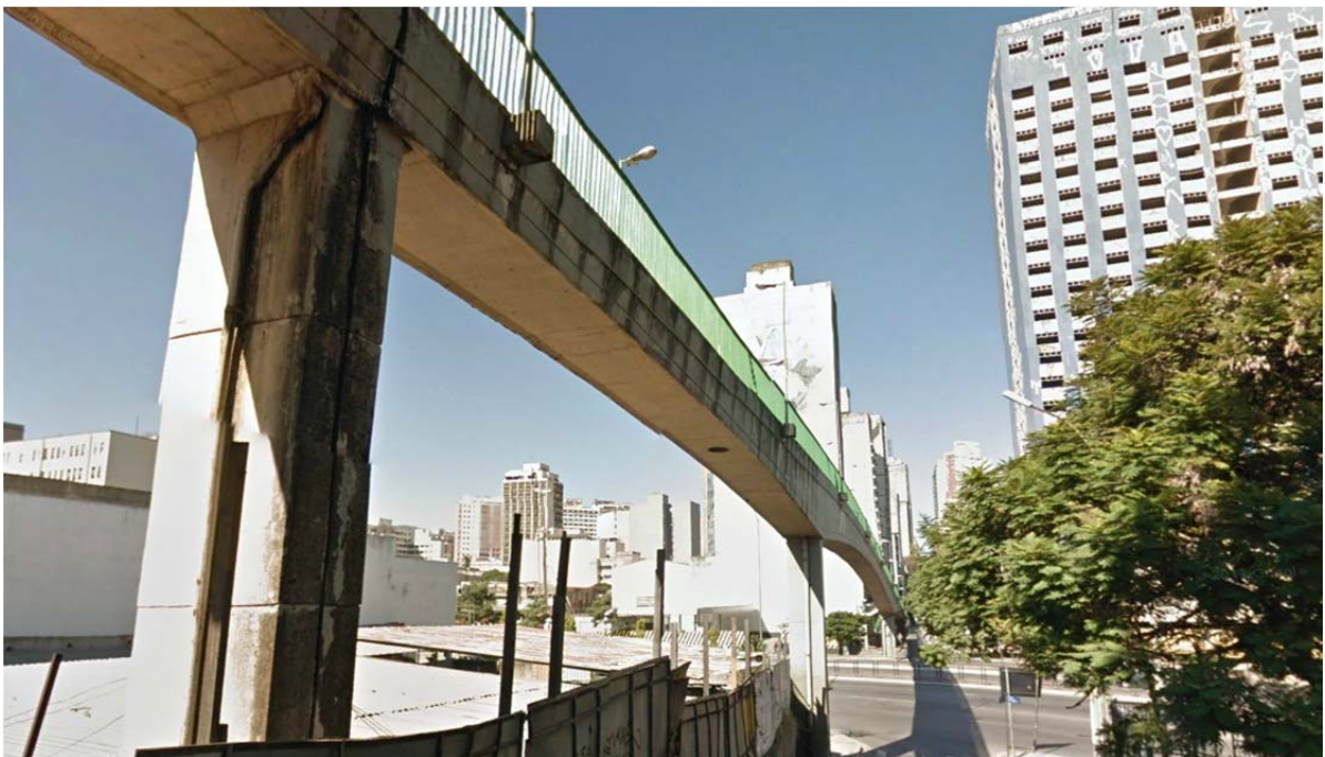
Figura 5.1 – Vista lateral da passarela da rua Varginha, Belo Horizonte/MG.
