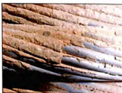
FIGURA 4.7 – Condutor da LT S.Lagoas 3 – Cominci utilizado nos ensaios
