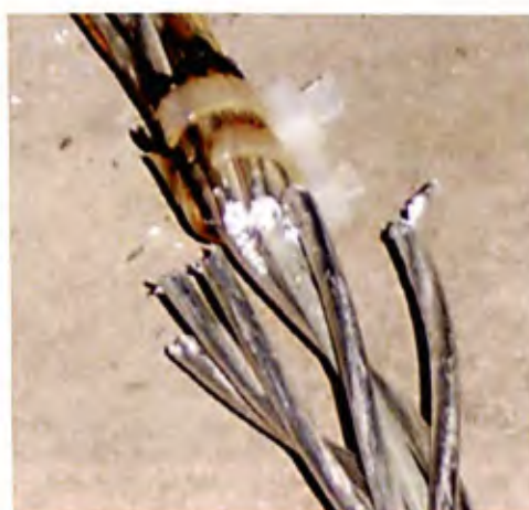
FIGURA 4. 2 – Situação da fixação após corte do 5º fio
