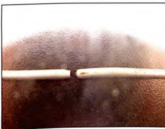
FIGURA 3. 6 – Fratura de um fio de aço do cabo Penguin
