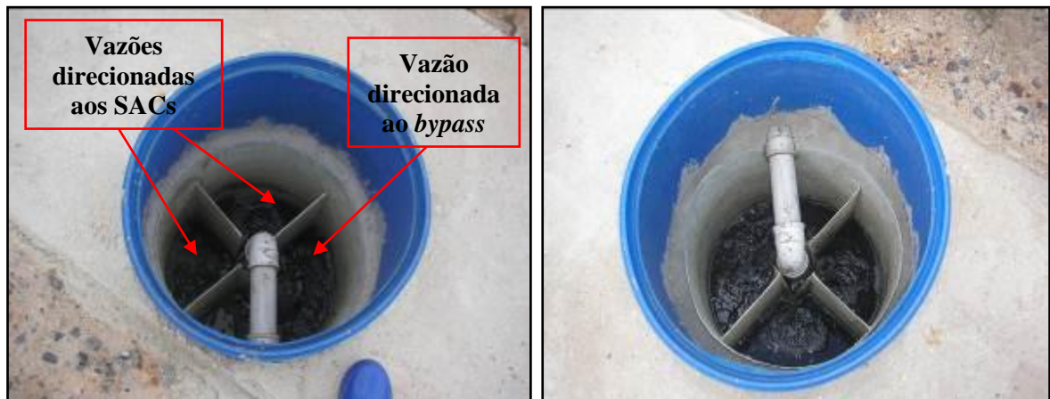
Figura 4.4 - Caixa distribuidora de vazão atual
