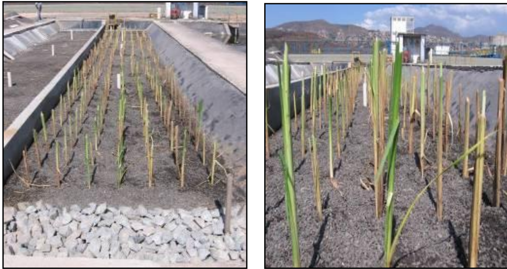
Figura 5.19 - Disposição das plantas durante o plantio no leito filtrante Fonte: Dornelas (2008).
