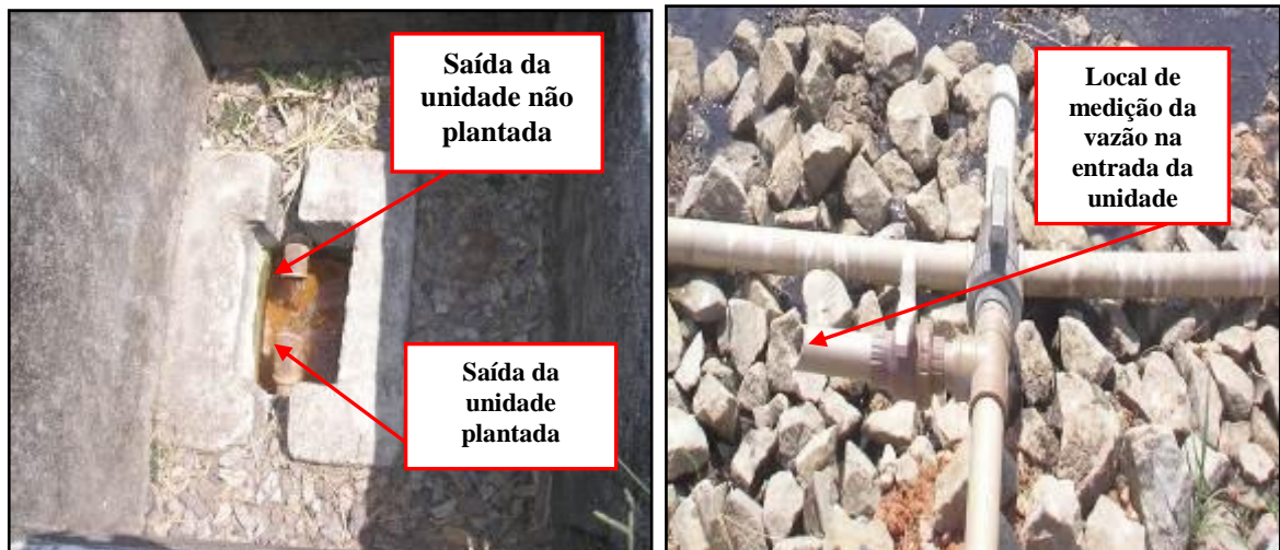
Figura 4.13 - Pontos de coleta de amostras e medição da vazão na entrada e saída das Unidades do SAC
