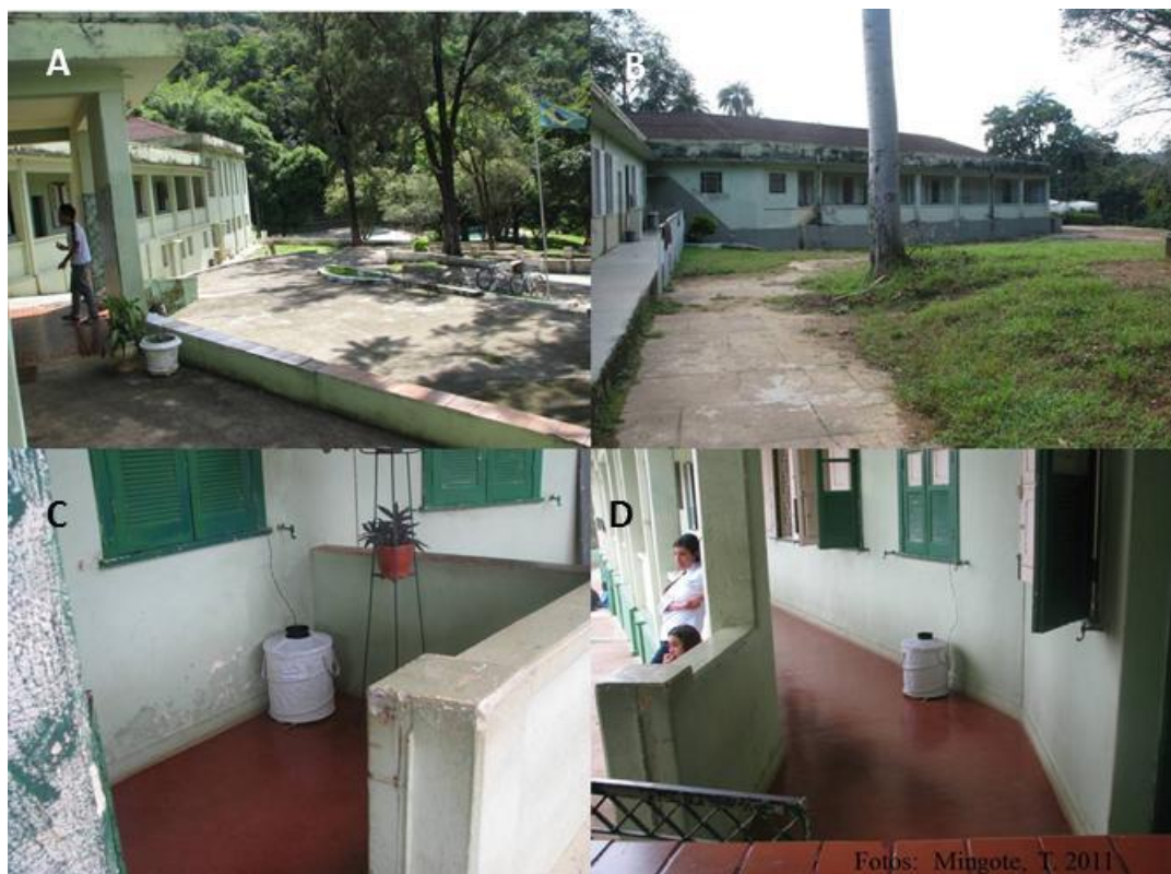
Figura 11- Edificação principal da Unidade Fazendinha, Sabará/MG, denominada de área da Escola. A. parte anterior da edificação com entrada principal; B. parte lateral da edificação; C. e D. exemplos de localização da armadilha BG-Sentinel® na área da Escola.
