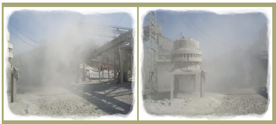
Figura 3.7 – Situação sem a utilização do sistema de abatimento de particulados Fonte: Fluidjet, 2011
