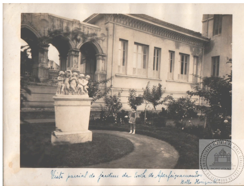
Figura 5. Vista Parcial do Jardim da Escola de Aperfeiçoamento, circa 1930. Fonte: Sala Helena Antipoff, Biblioteca Central da UFMG.
