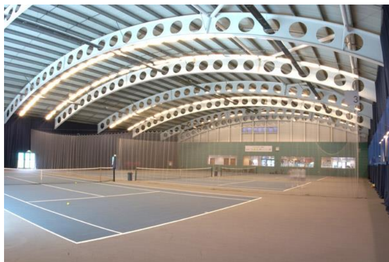
Figura 1.3 – Vigas celulares aplicadas em um ginásio poliesportivo (fonte: www.westok.co.uk – acessado em 23/12/2012).
