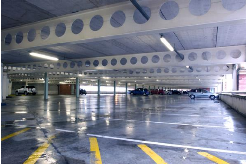
Figura 1.13 – Aplicação de vigas celulares em sistemas de garagem, Fairhill Car Park, Ballymena (fonte: www.westok.co.uk – acessado em 23/12/2012).
