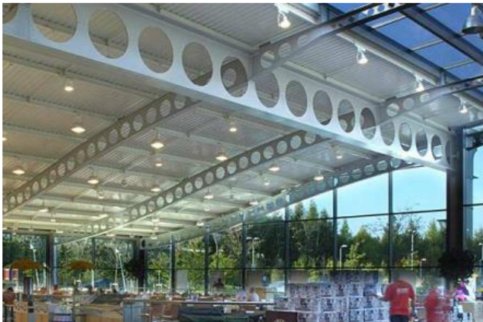
Figura 1.8 – Aplicação de vigas celulares curvas, Winchester (Erdal, 2011).
