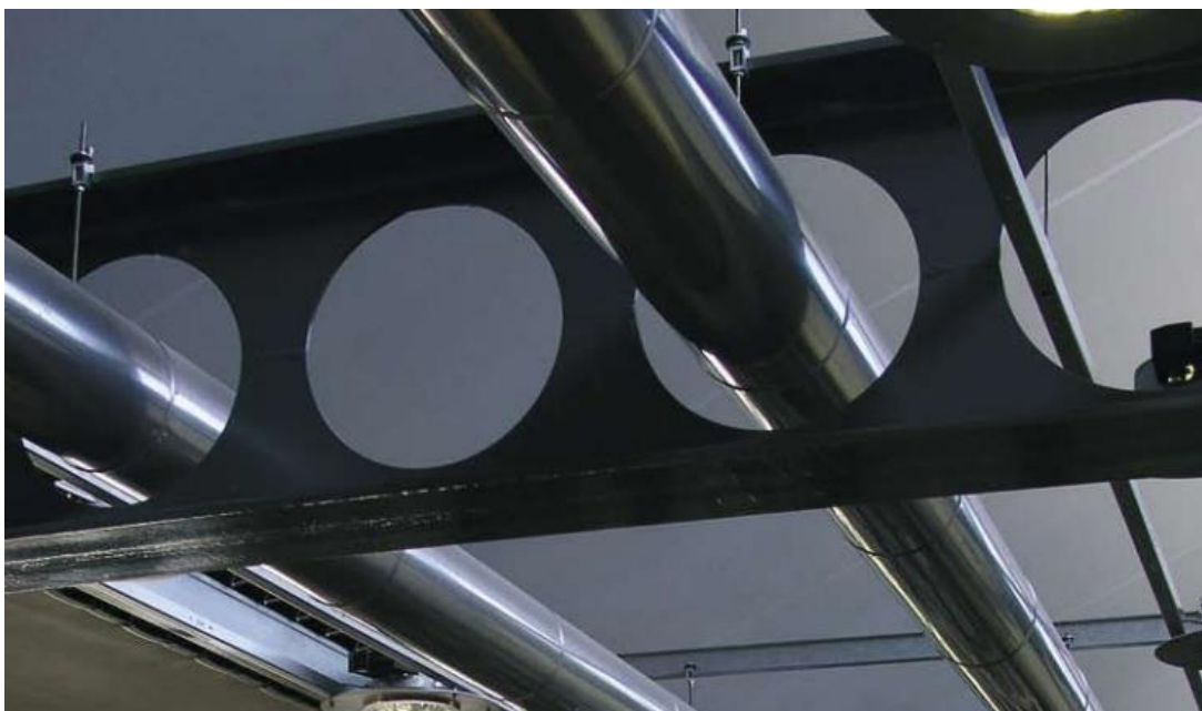
Figura 1.11 – Disposição das tubulações dentro das aberturas das vigas celulares (fonte: www.arcelormittal.com – acessado em 11/12/2012).
