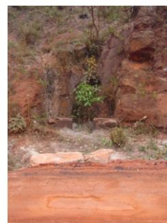
FIGURA 109 - Em primeiro plano, leito com afloramento de laje do teto do bueiro. Ao fundo, corte na rocha no local da entrada do bueiro.
