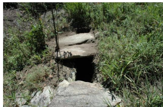
FIGURAS 45 e 46 - Bueiro: entrada (seta); lajes superiores parcialmente desmoronadas.
