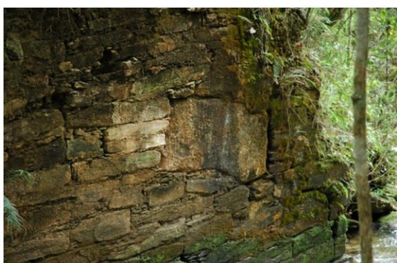
FIGURA 168 - Cortina da ponte: permite ver os blocos lavrados na face externa e calçados com pedras menores.
