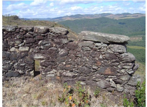
FIGURAS 36 e 37 - Segmento 1 - Muro de pedras. Na parte inferior, blocos em estado semi-bruto. Na parte mediana, blocos melhor organizados permitem a aplicação de reboco, cujos vestígios ainda são visíveis. Na parte superior, blocos lavrados.
