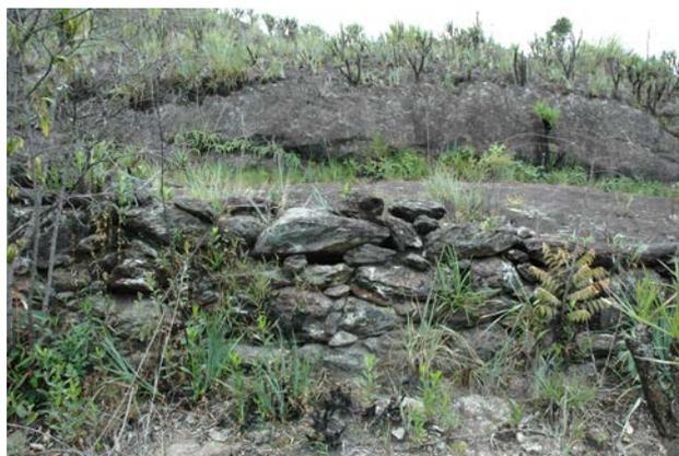
FIGURA 9 - Caminho Novo: Segmento 1. Corte (em segundo plano) e arrimo de pedras (em primeiro plano).
