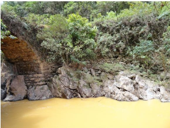
FIGURA 177 - Ponte Tabuões: vista 2. Arrimo se estendendo à direita da ponte.
