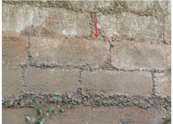
FIGURA 162 - Detalhe da linha da base onde tem início a abóbada (seta).
