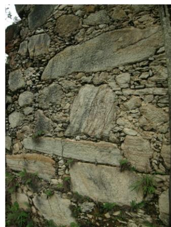
FIGURAS 135; 136; 137 - Aduela de nascença (seta) sobre pilar; base assentada sobre o afloramento rochoso; detalhe que permite ver a técnica construtiva do arrimo.
