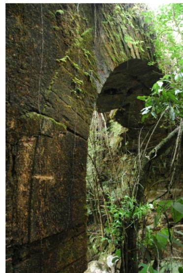
FIGURA 172 - Detalhe das aduelas: lava fina conformando a linha do intradorso e entalhe marcando a linha do extradorso.
