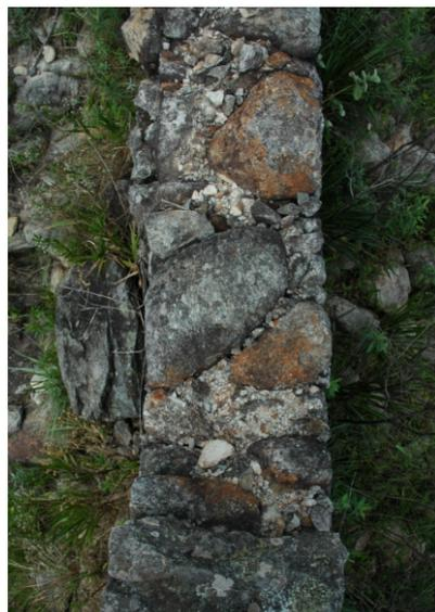
FIGURAS 41 e 42 - Segmento 1: Muro de pedras. Parte superior arrematada com blocos lavrados. Em alguns pontos, a ausência dos blocos revela o tipo de rejuntamento (pedregulhos e barro).
