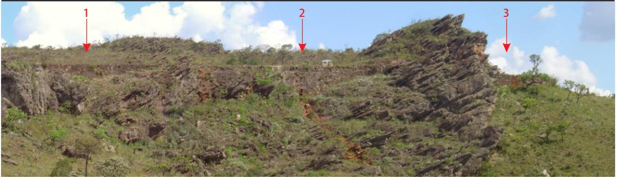
FIGURA 102 - Estrada (inacabada) do Paraibuna: conjunto de arrimos (setas) com galeria, bueiro e drenos.
