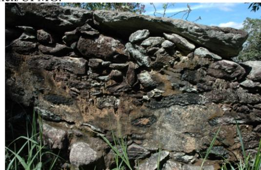
FIGURA 49 e 50 - Muro de pedras e parte do leito da estrada; vestígios de reboco no muro.
