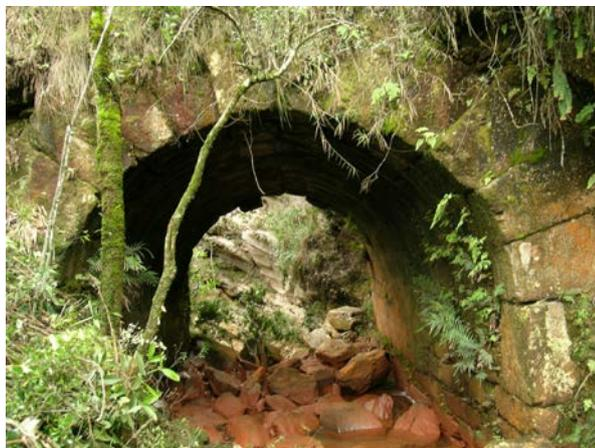
FIGURA 17 - Estrada (Inacabada) do Paraibuna: Ponte Inacabada. Detalhe das aduelas.
