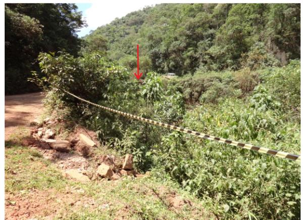
FIGURA 178 - Ponte Tabuões: em primeiro plano início do arrimo (desmoronado). Seta indicando localização da ponte.
