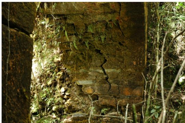
FIGURA 167 - Vão em abóbada. Detalhe das rachaduras.
