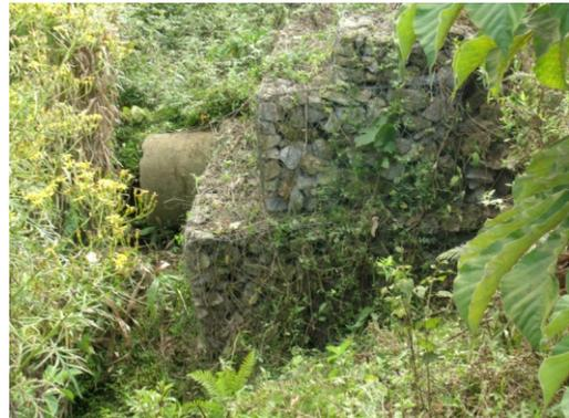
FIGURA 118 - Saída do bueiro com manilha de concreto.
