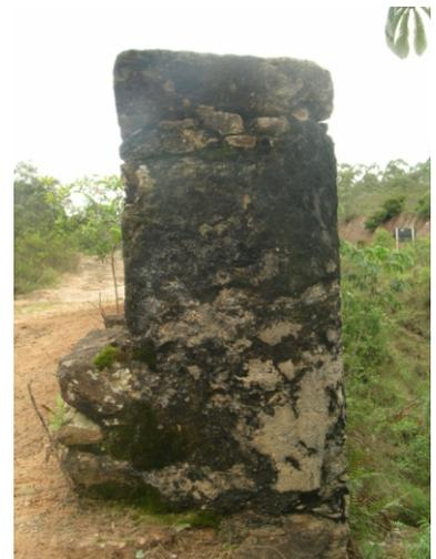
FIGURAS 144 e 145 - Peitoril com respaldo em blocos lavrados ortogonalmente e detalhe do peitoril sobre sapata.
