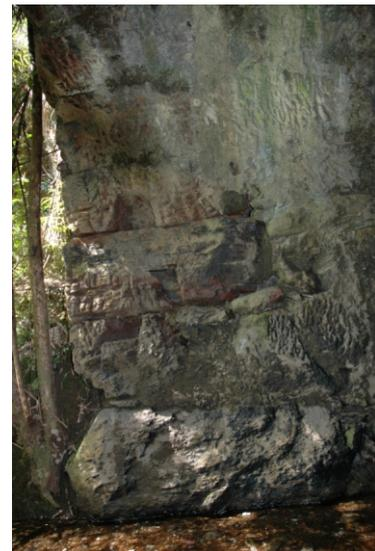
FIGURA 60 - Ponte do Tripuí. Detalhe da base, destaque para blocos lavrados.
