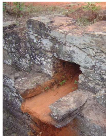
FIGURA 11 - Estrada (Inacabada) do Paraibuna: saída de bueiro com gárgula.
