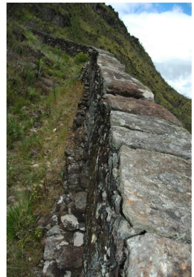
FIGURA 43 - Segmento 1: Muro de pedras. Detalhe: base mais larga.
