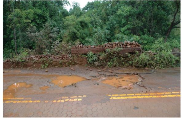
FIGURA 149 - Peitoril parcialmente destruído. Alguns paralelepípedos da MG-129 foram colocados por cima dele.
