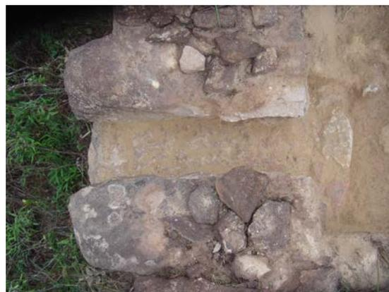
FIGURA 15 - Estrada (Inacabada) do Paraibuna: dreno com gargula.
