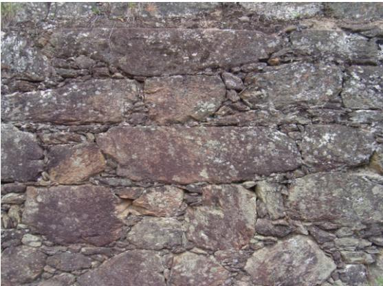
FIGURA 112 - Detalhe do arrimo, com assentamento tipo canjicado.
