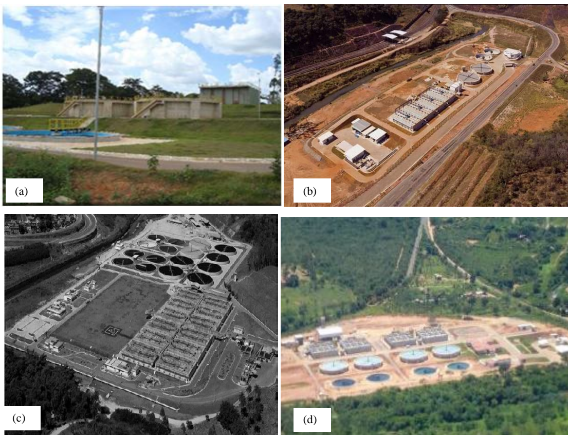
FIGURA 3.5: ETEs com sistema UASB/FPB: (a) ETE São José da Lapa (40 L/s); (b) ETE Laboreaux - Itabira (168 L/s); (c) ETE Onça – Belo Horizonte (1800 L/s); (d) ETE Vieiras – Montes Claros (500 L/s). Fonte: COPASA (2012) SAAE-Itabira (2012).
