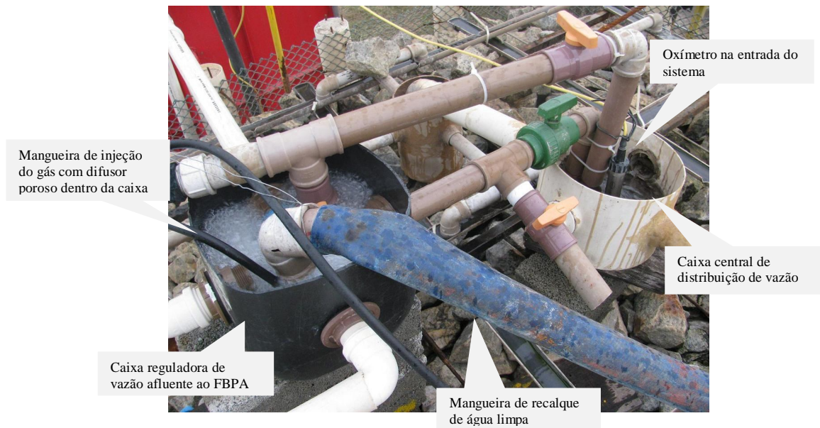
FIGURA 5.10: Detalhe da injeção do gás traçador na água limpa dentro da caixa reguladora de vazão.
