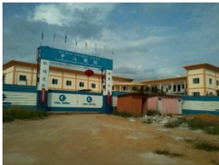
FIGURA 7 - Escola do Ensino Primário de Zôngolo, em construção, em 2013
